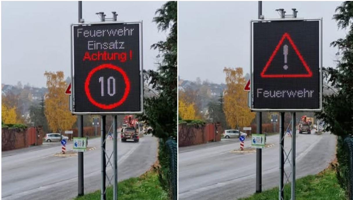
Abb. 27: Verkehrswarnanlage der Freiwilligen Feuerwehr der Stadt Birkenfeld
