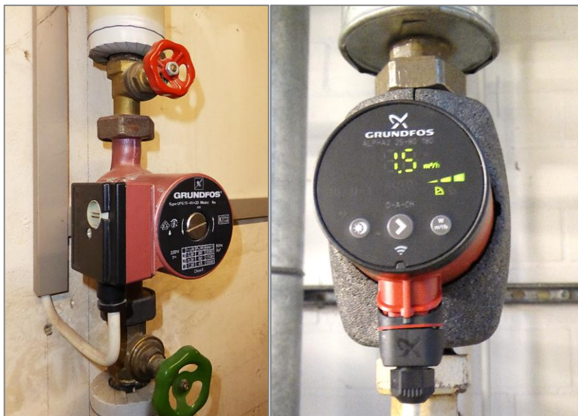
Austausch/Einstellen der Pumpen
